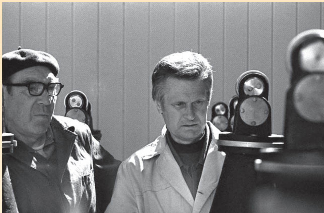
Наладка механизмов компенсации деформаций главного зеркала БТА.
