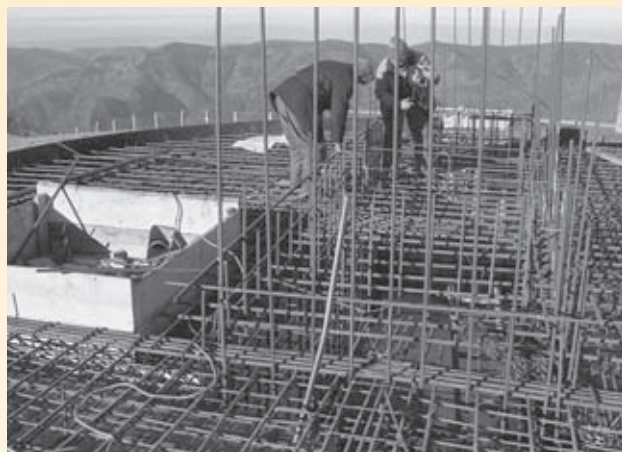
Арматурные работы на перекрытии второго этажа.
