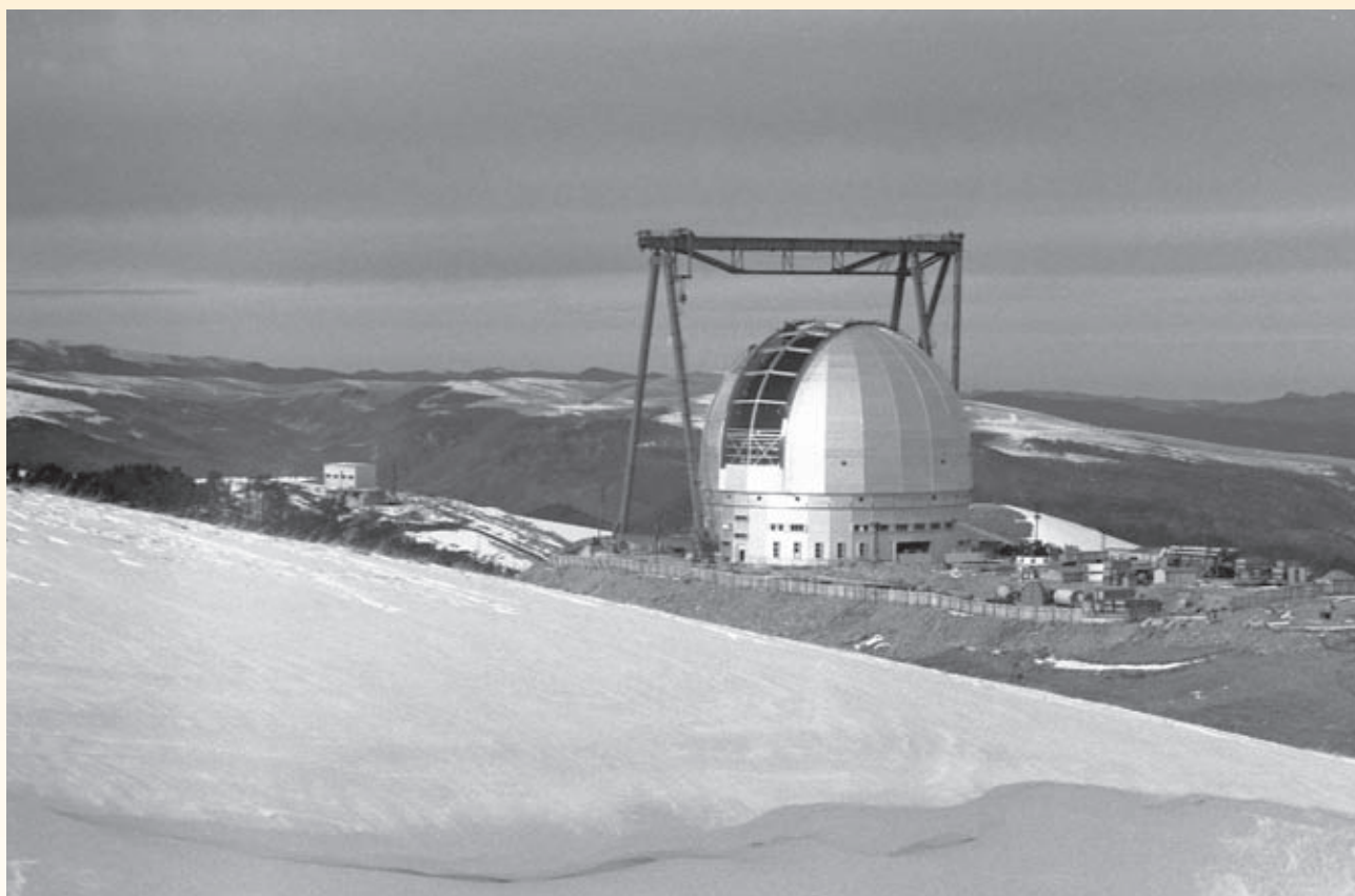
Конец 1969 г. Облицовка купола завершена.
