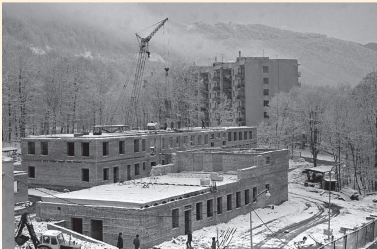
Декабрь, 1984 г. Строительство школы идёт ударными темпами.
