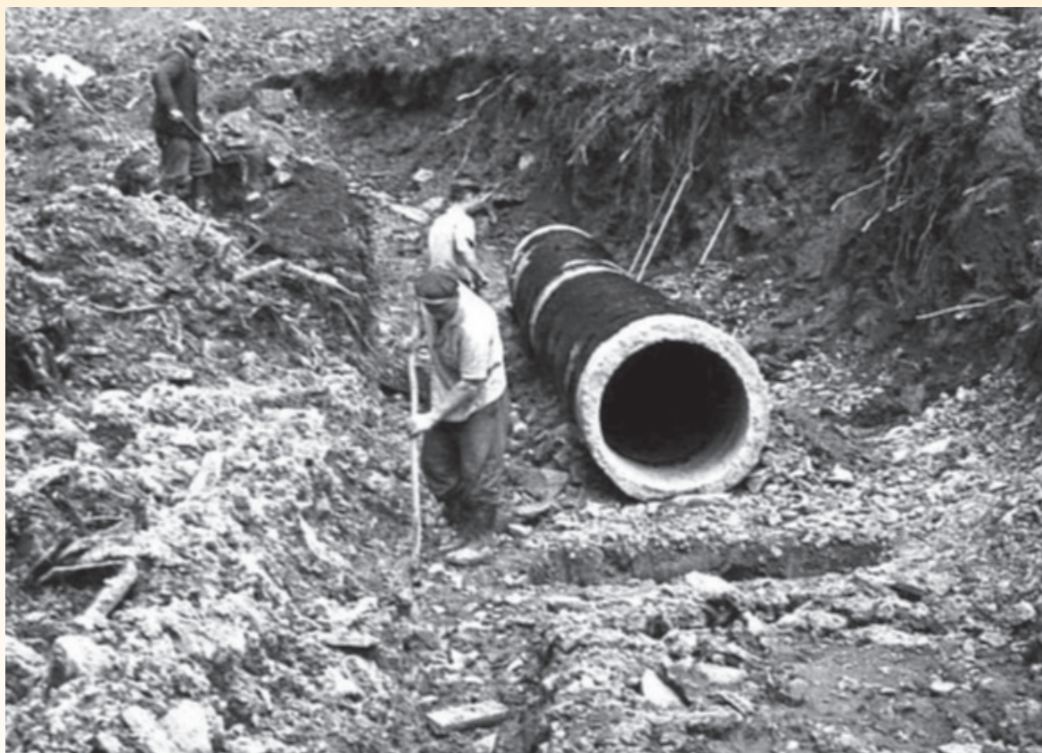
Большое количество родников и ручьев на склонах привело к необходимости устройства каналов и укладки дренажных труб под будущим полотном трассы. Июнь, 1965 г.
