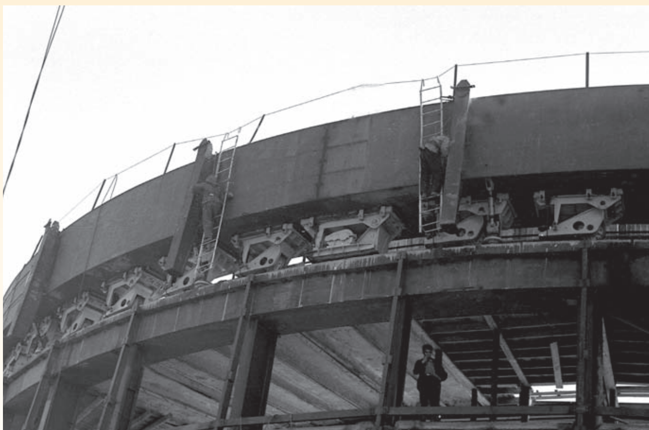
Сборка вращающегося основания купола
