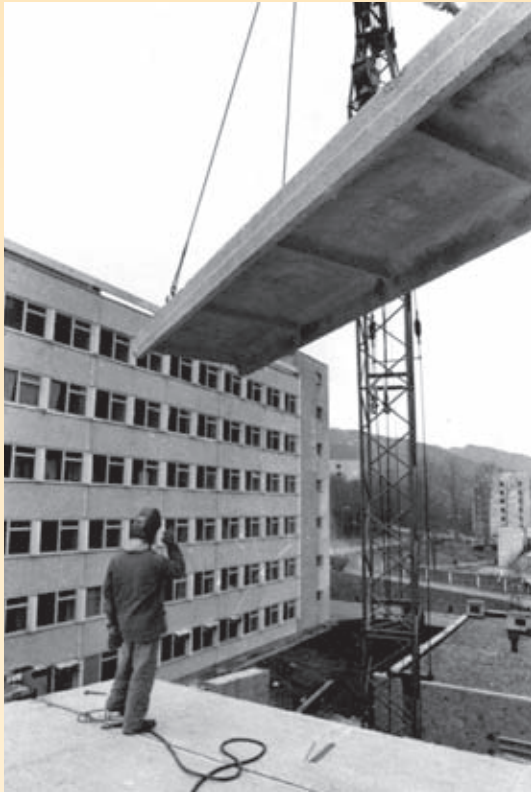
Строительство Лабораторного корпуса и конференцзала. 1981 г.
