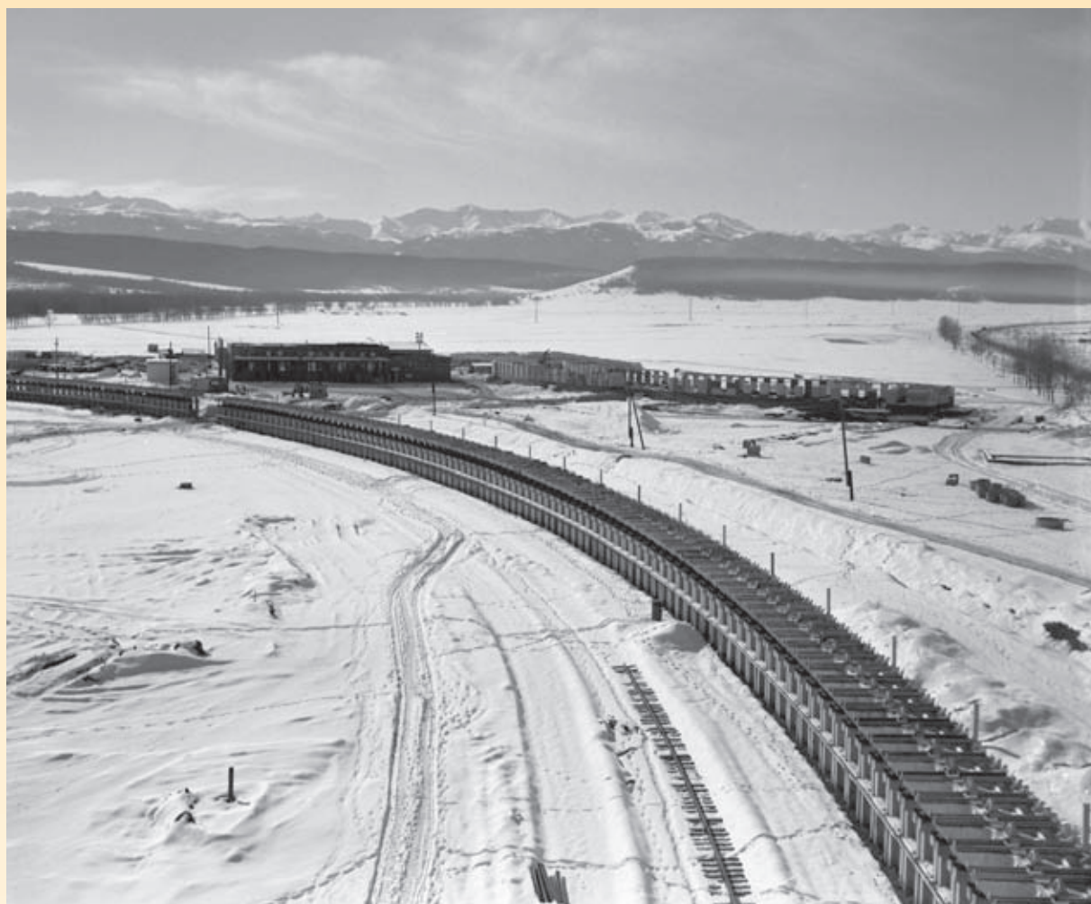
Сборка опор антенны радиотелескопа.
