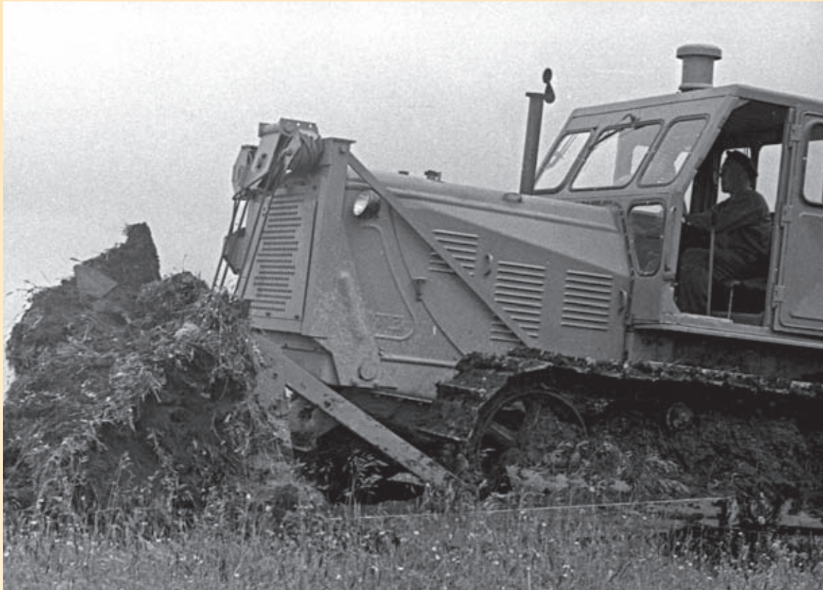
День начала строительства на Верхней площадке САО – 11 июля 1965 г.
