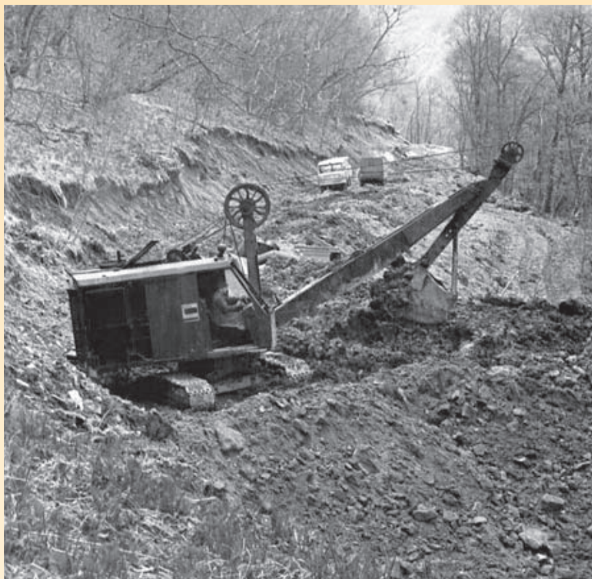
Большое количество родников и ручьев на склонах привело к необходимости устройства каналов и укладки дренажных труб под будущим полотном трассы. Июнь, 1965 г.
