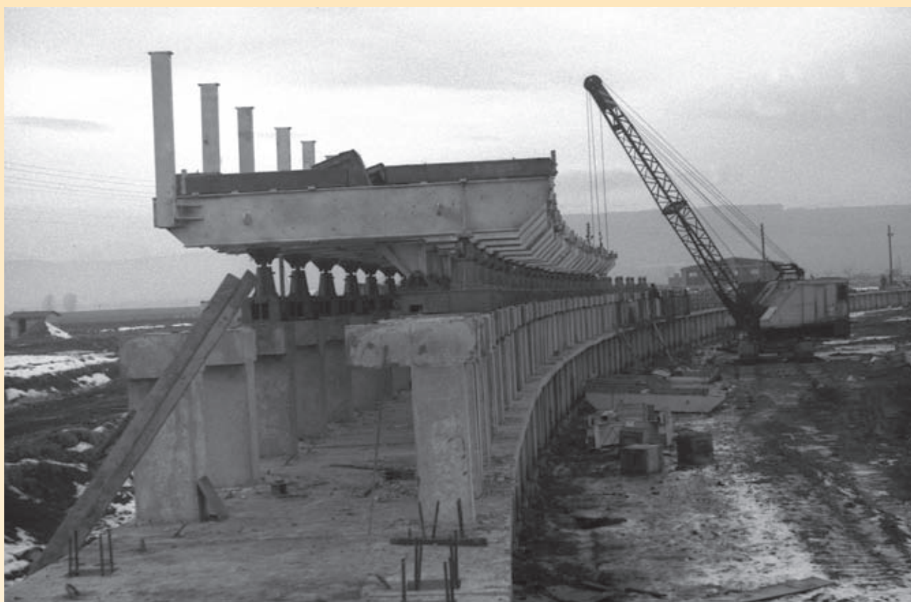
Монтаж металлоконструкций кольцевой антенны. 1970 г.
