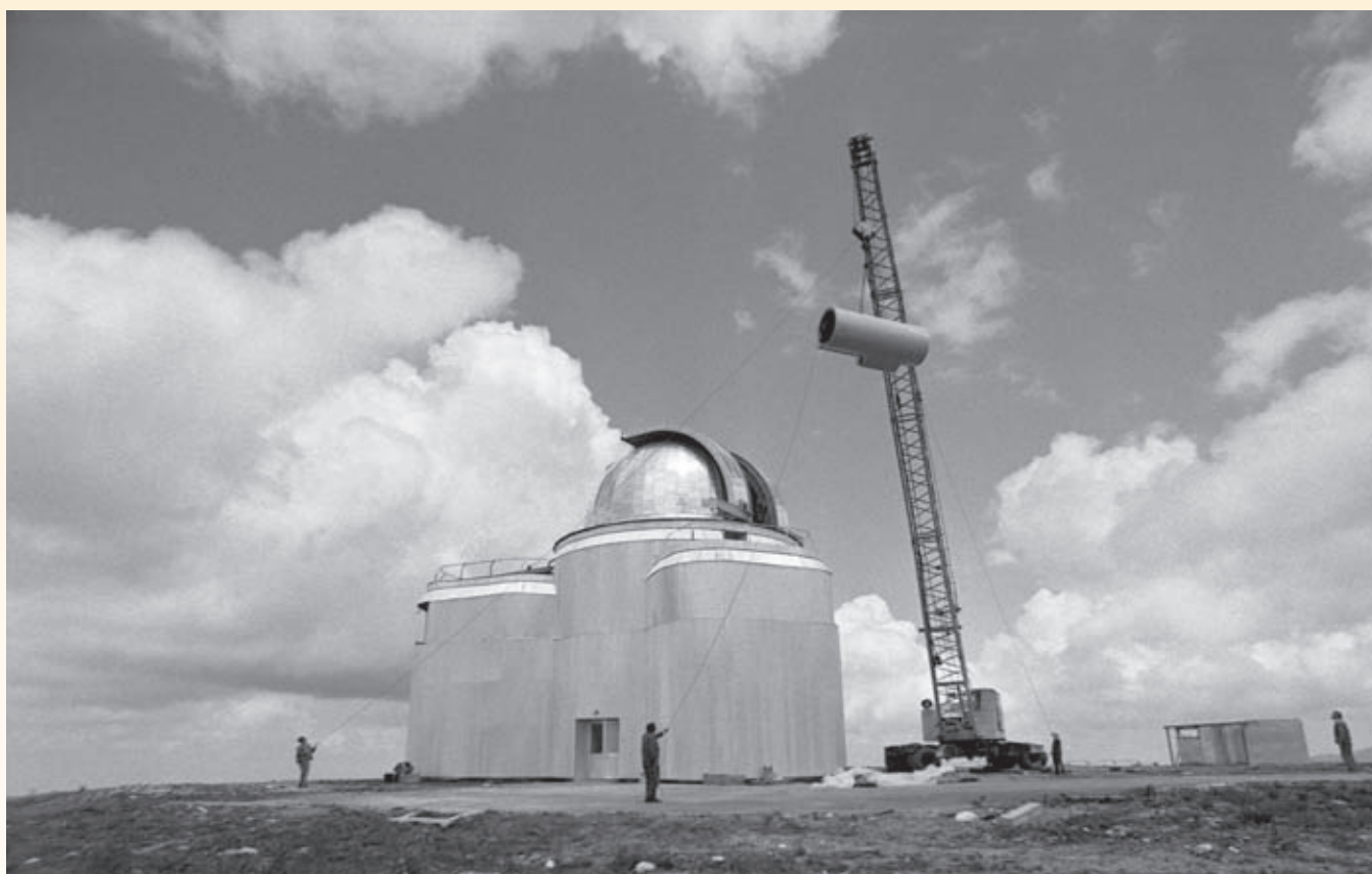
Монтаж трубы 1-метрового телескопа.
