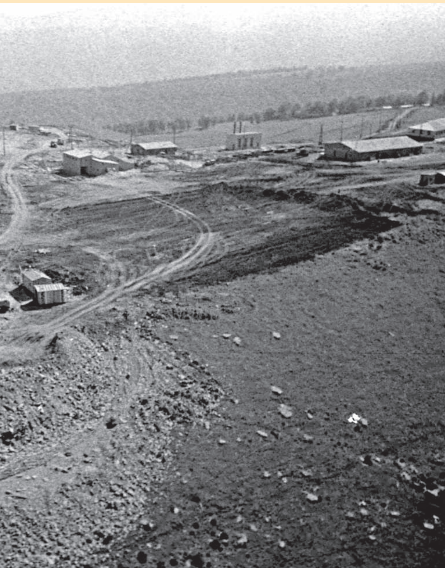
Вид стройплощадки БТА с вертолѐта, апрель, 1966 г.
