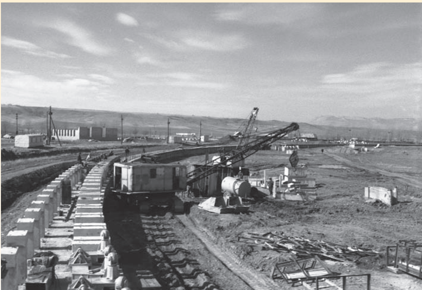
Установка железобетонных антенных опор . 1969 г.
