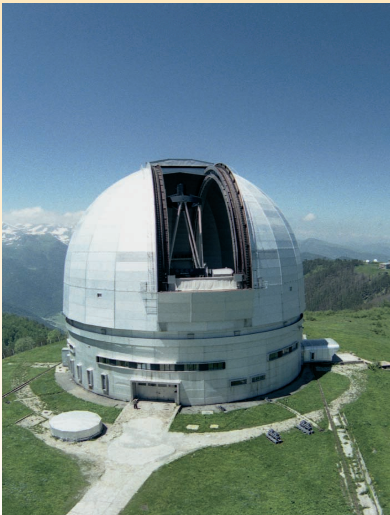
Башня 6-метрового телескопа БТА. Высота сооружения – 53 метра
