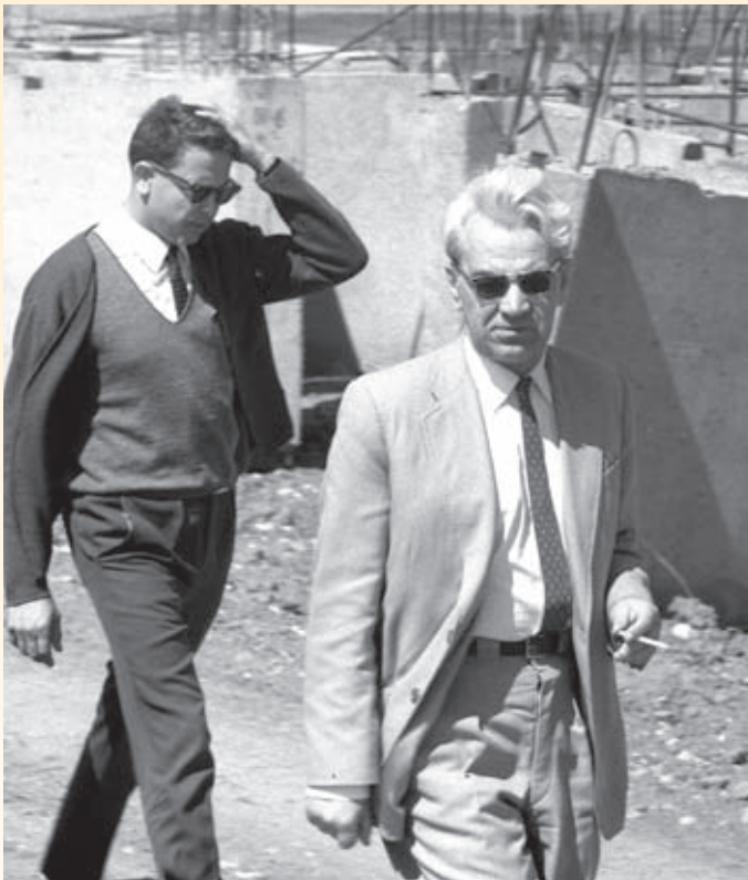
Осмотр стройки. М.В. Келдыша сопровождает директор СНО Ю.Е. Якунин. 17 июля 1969 г.
