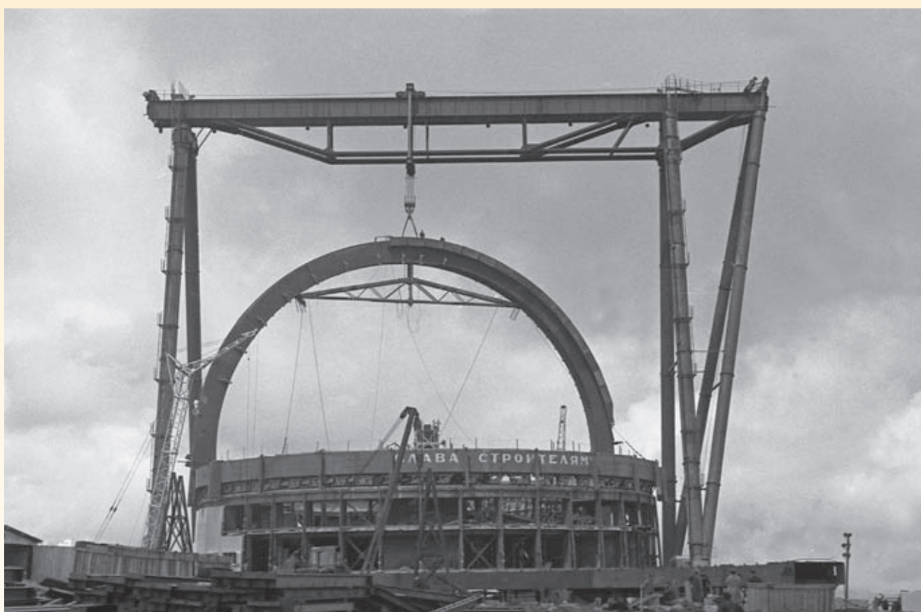
Установка первой опорной дуги купола. Лето, 1968 г.
