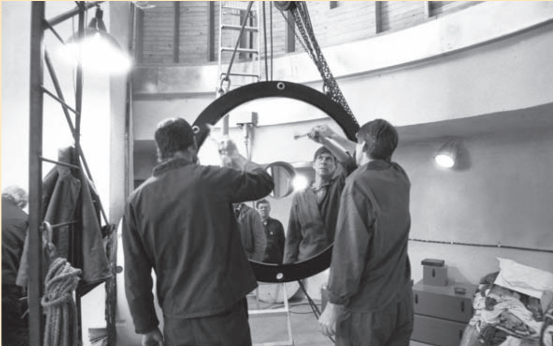
Главное зеркало 1-метрового телескопа...
