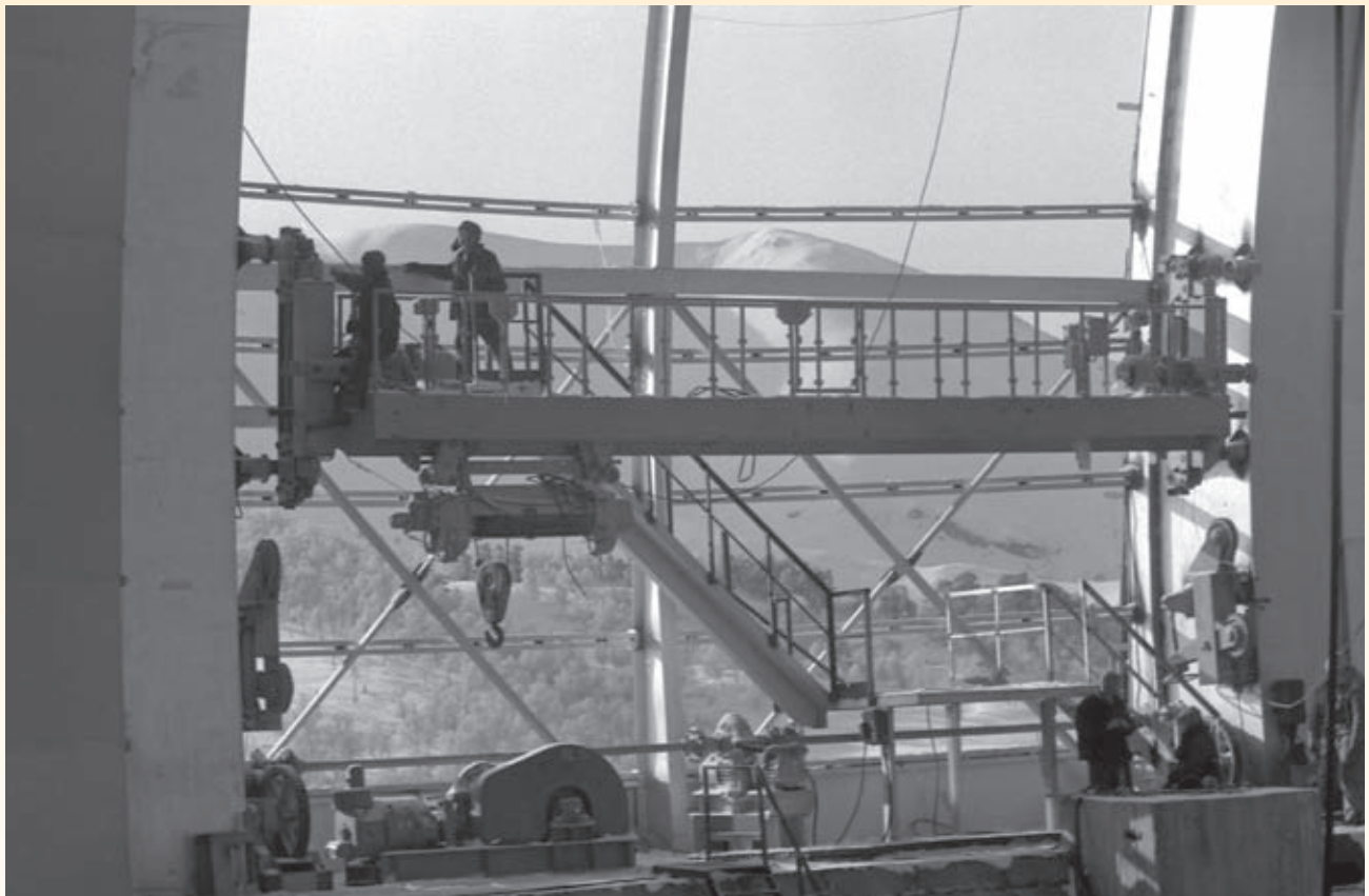
Монтажники «Южстальконструкции» ведут сборку механизмов забрала башины БГА. Декабрь-январь 1969 г.
