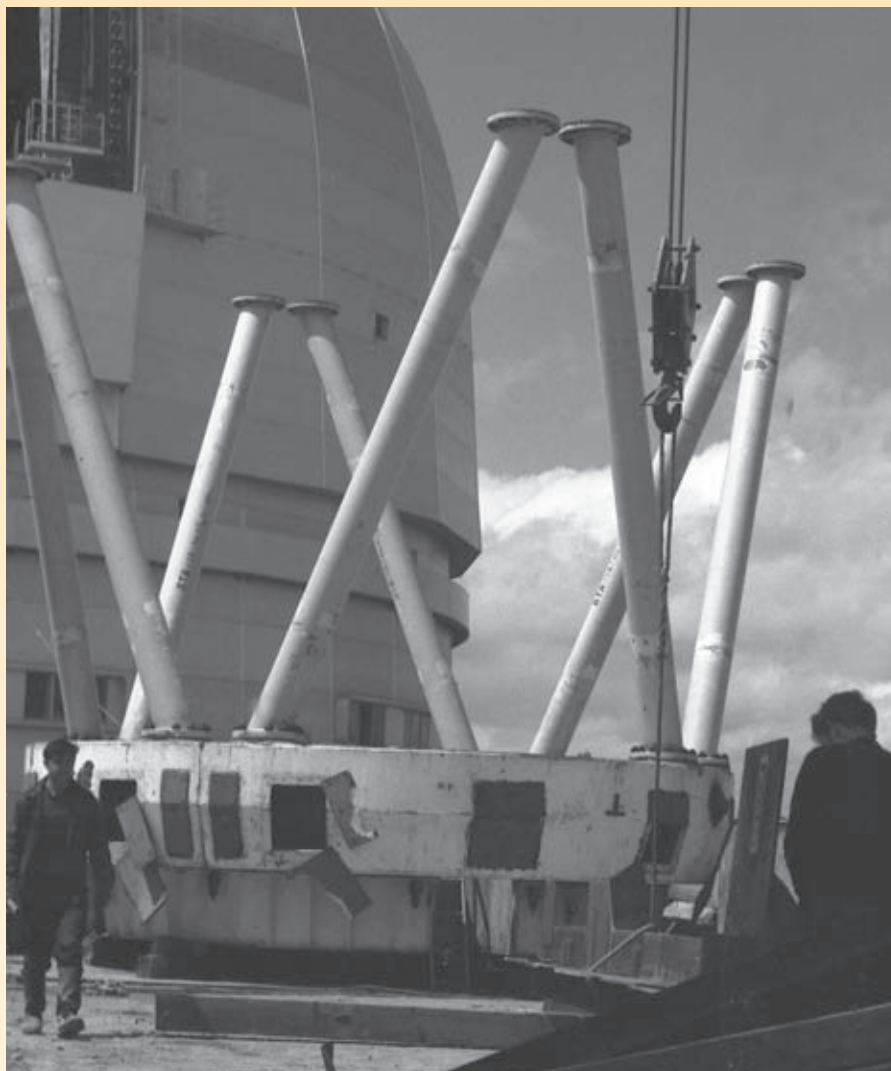
Сборка и монтаж нижней части трубчатой конструкции БТА.
