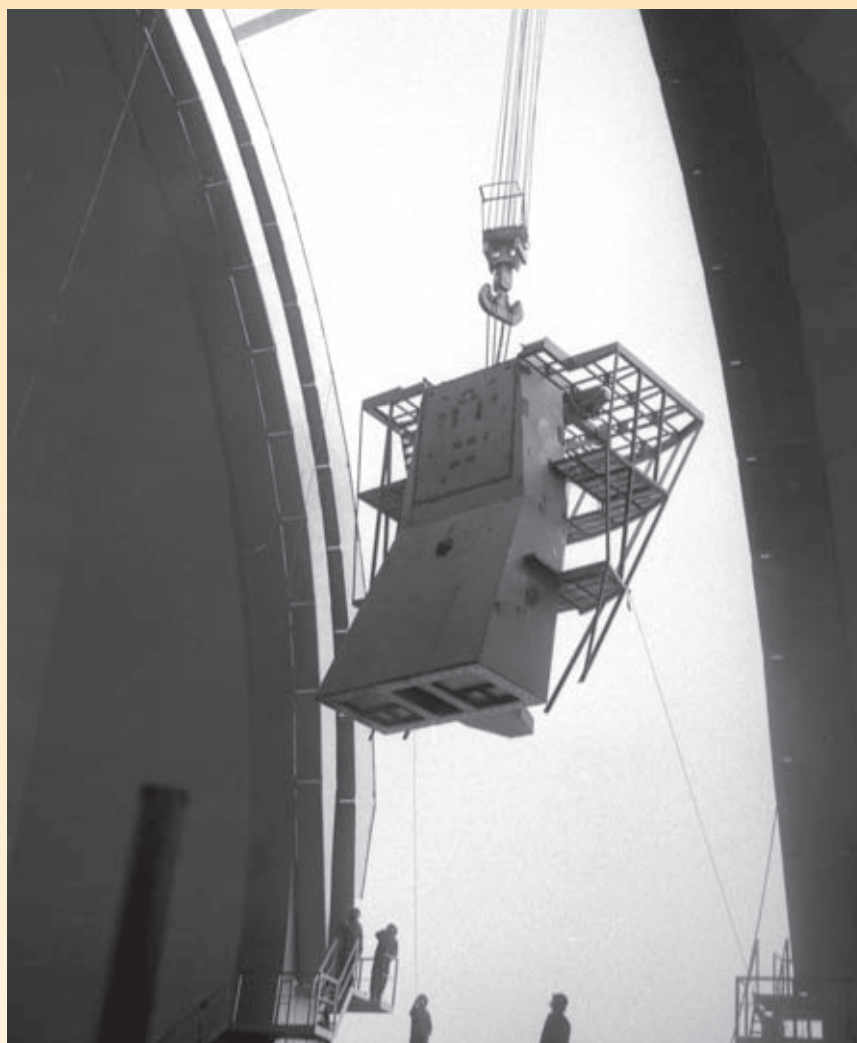
Монтаж стоек БТА. Лето 1970 г.
