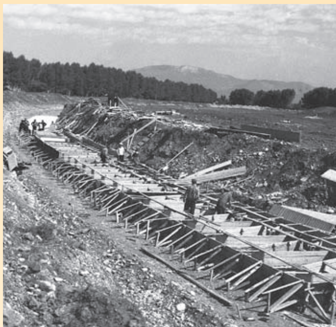
Подготовка опалубки под заливку бетона в основание опор антенны РАТАН-600. 1969 г.
