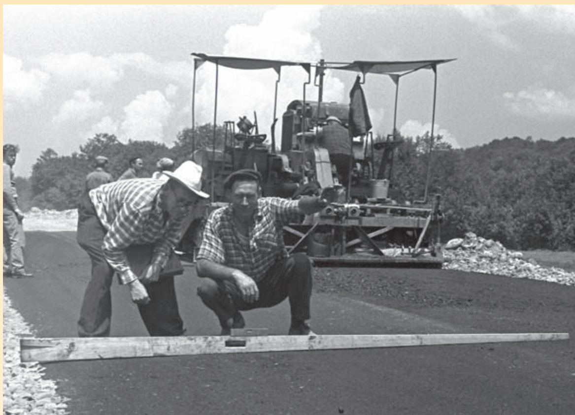
Укладка и контроль профиля дорожного покрытия. Лето, 1966 г.
