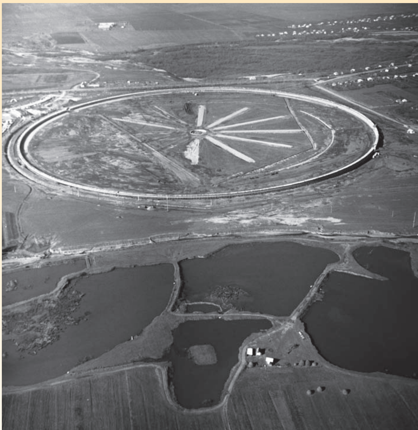
Панорама строительства РАТАН - 600 с воздуха. 1970 г. На снимке хорошо просматриваются железобетонные опоры под главное зеркало телескопа, расположенные по окружности, центральный поворотный круг и радиальные фундаменты под рельсовые пути радиоприёмных кабин.
