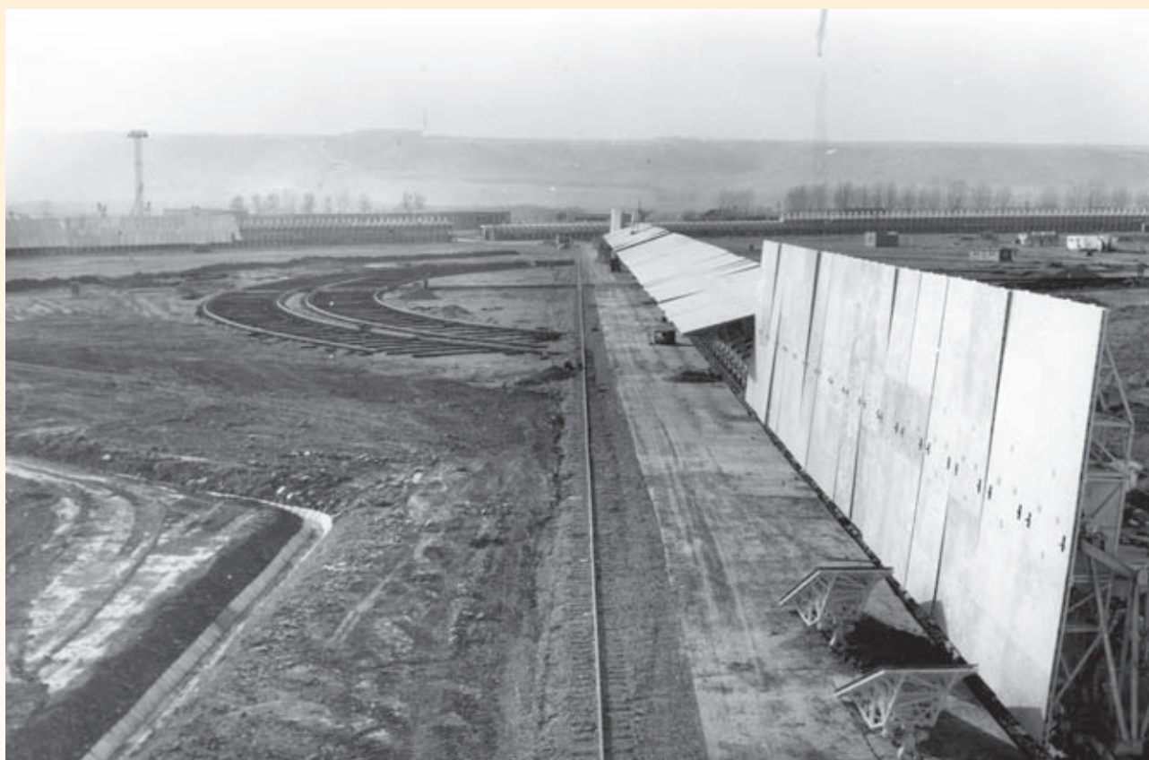
Сборка плоского зеркала радиотелескопа.
