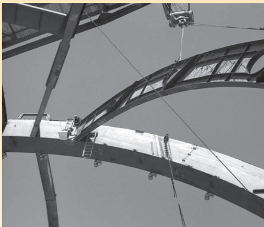
Сборка каркаса купола башни. Лето, 1968 г.
