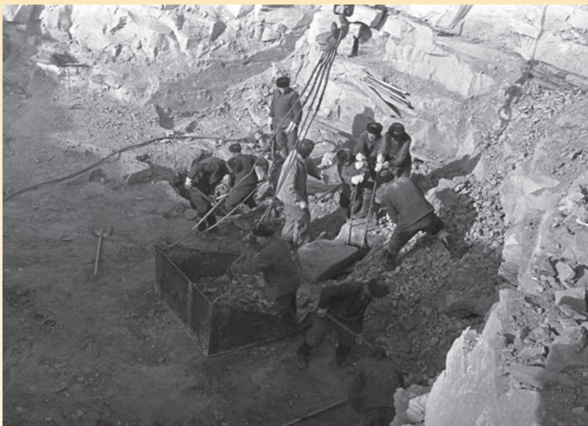
Январь, 1966 г. Подготовка котлована под фундамент телескопа БТА. В основании телескопа и башни БТА – плита камня-песчаника. Для сохранения монолитности этой плиты взрывные технологии при проходке не применялись. Работы велись практически вручную, с использованием отбойных молотков и перфораторов.
