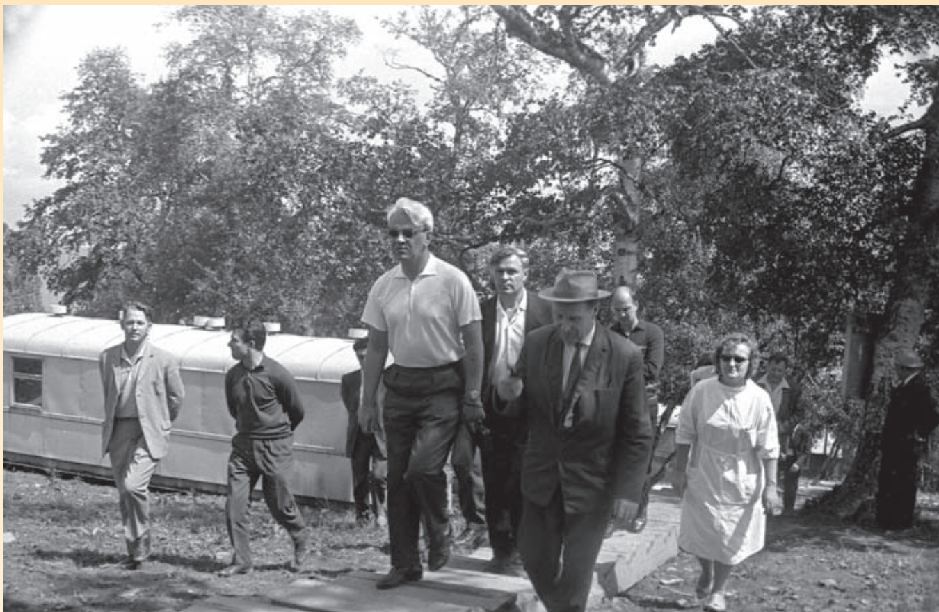
Осмотр жилого поселка строителей.
