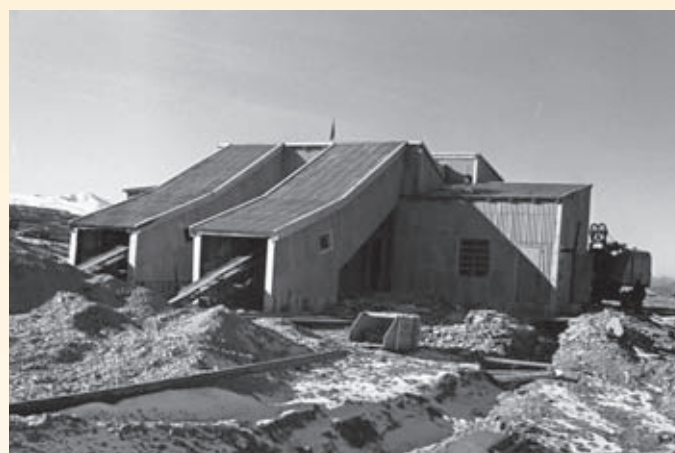
Бетонно-растворный узел, декабрь, 1965 г.
