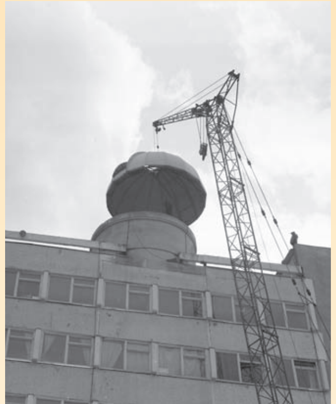
Установка куполов на крыше ЛК. 1985 г.
