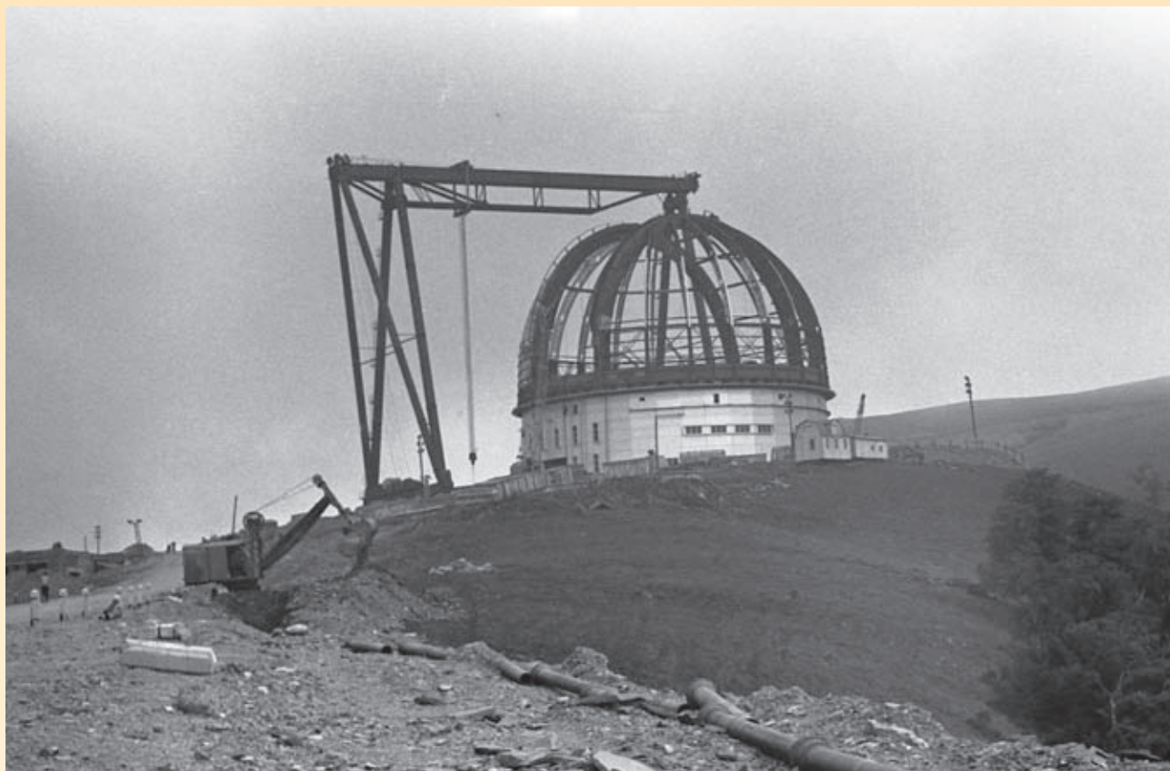
Каркас купола башни смонтирован. Лето, 1968 г.
