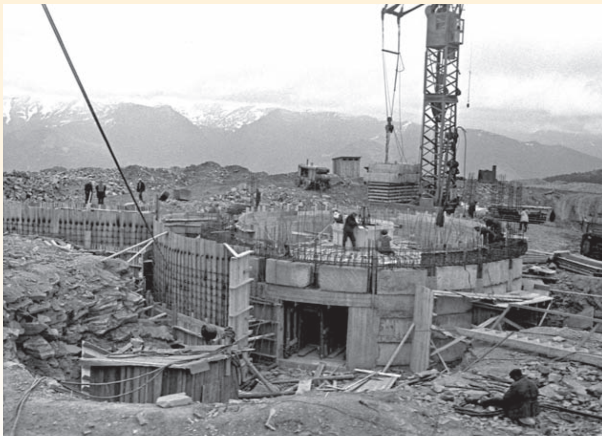
Строительство фундамента телескопа БТА. Апрель-май 1966 г.
