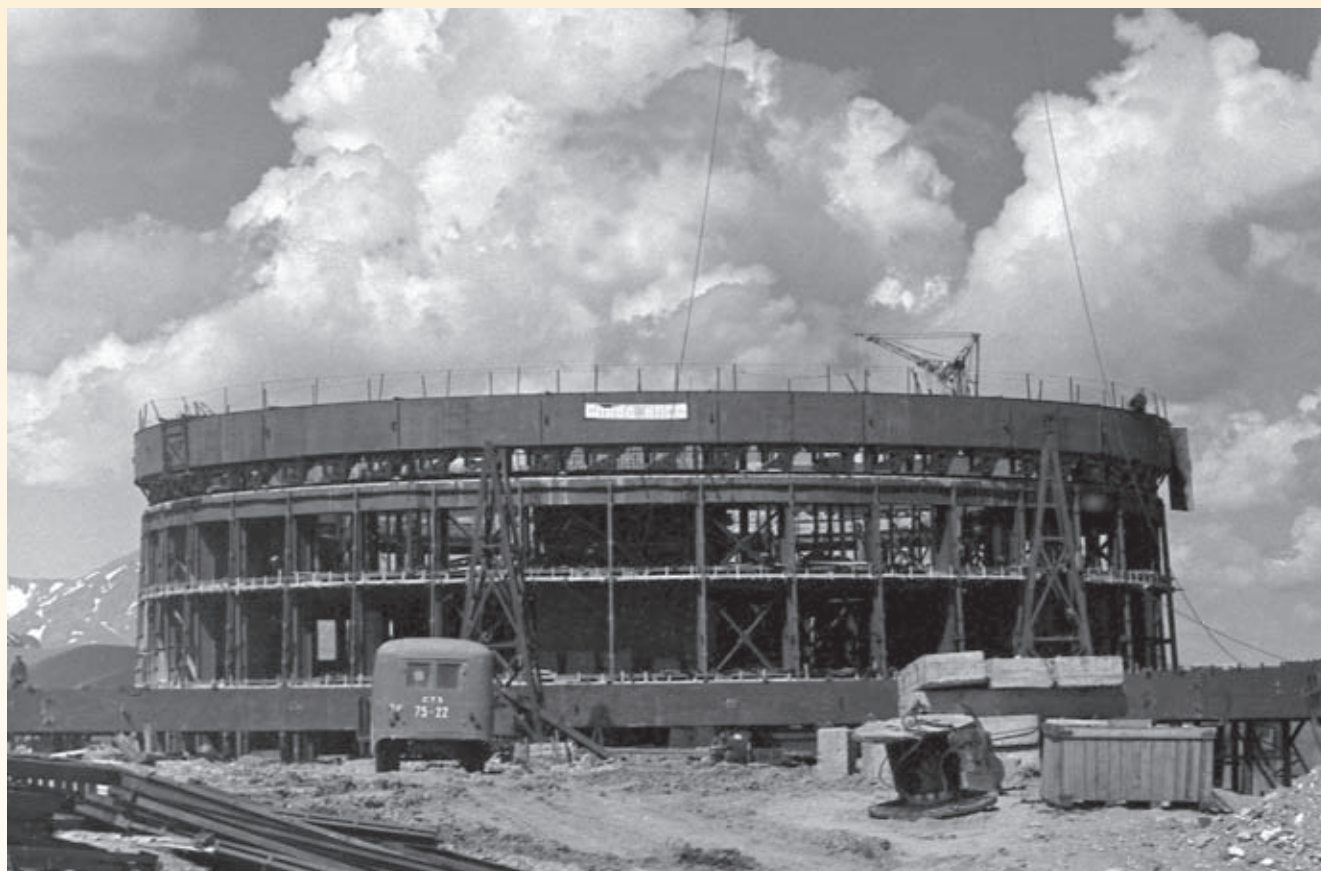
Монтаж каркаса помещений башни. Работы ведет Ростовское управление треста «Южстальконструкция». 1967 г.
