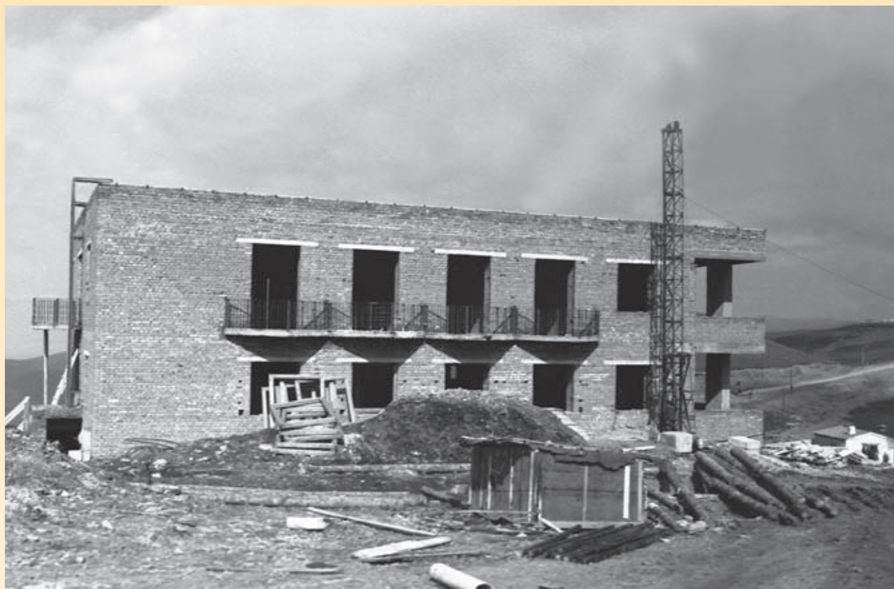
Строительство гостиницы ВПП. 1969 г.
