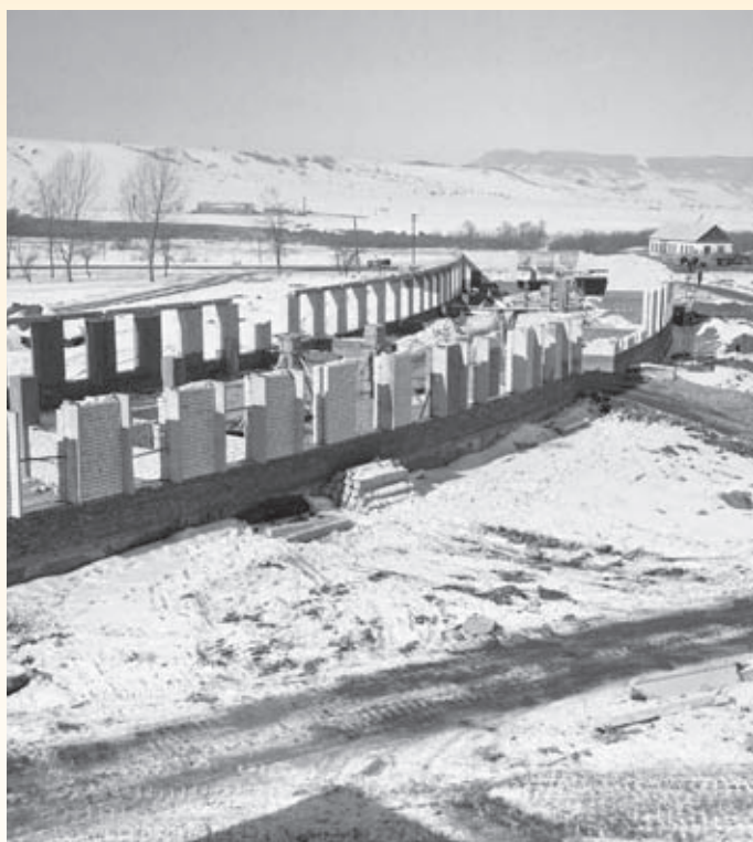
Строительство лабораторного корпуса.
