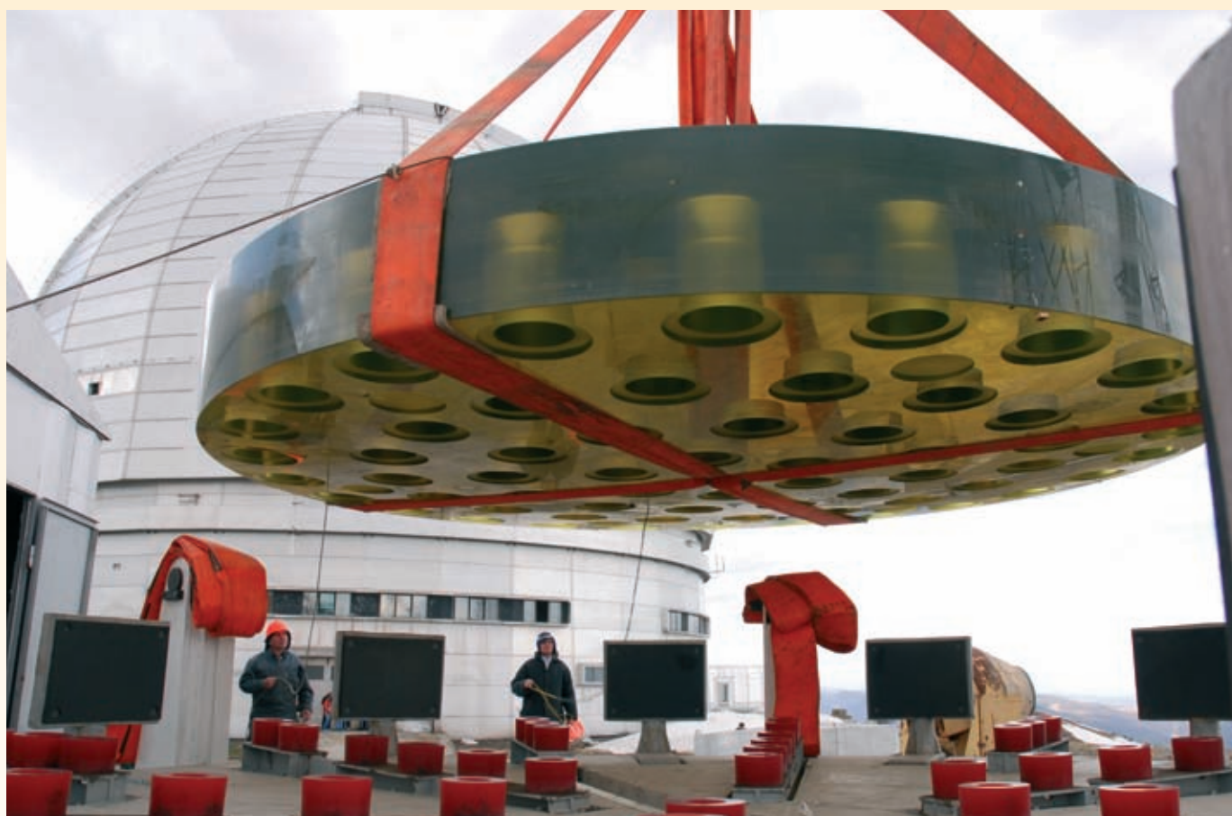
Установка зеркала в транспортный контейнер...
