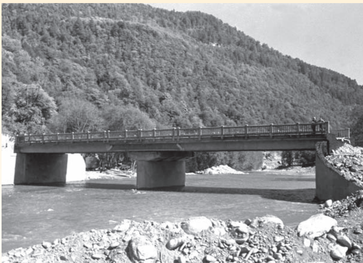
Мост через р. Б. Зеленчук возле пос. Нижний Архыз был построен в сентябре 1965 г. Все мосты основной дороги должны были выдерживать нагрузку не менее 100 тонн.
