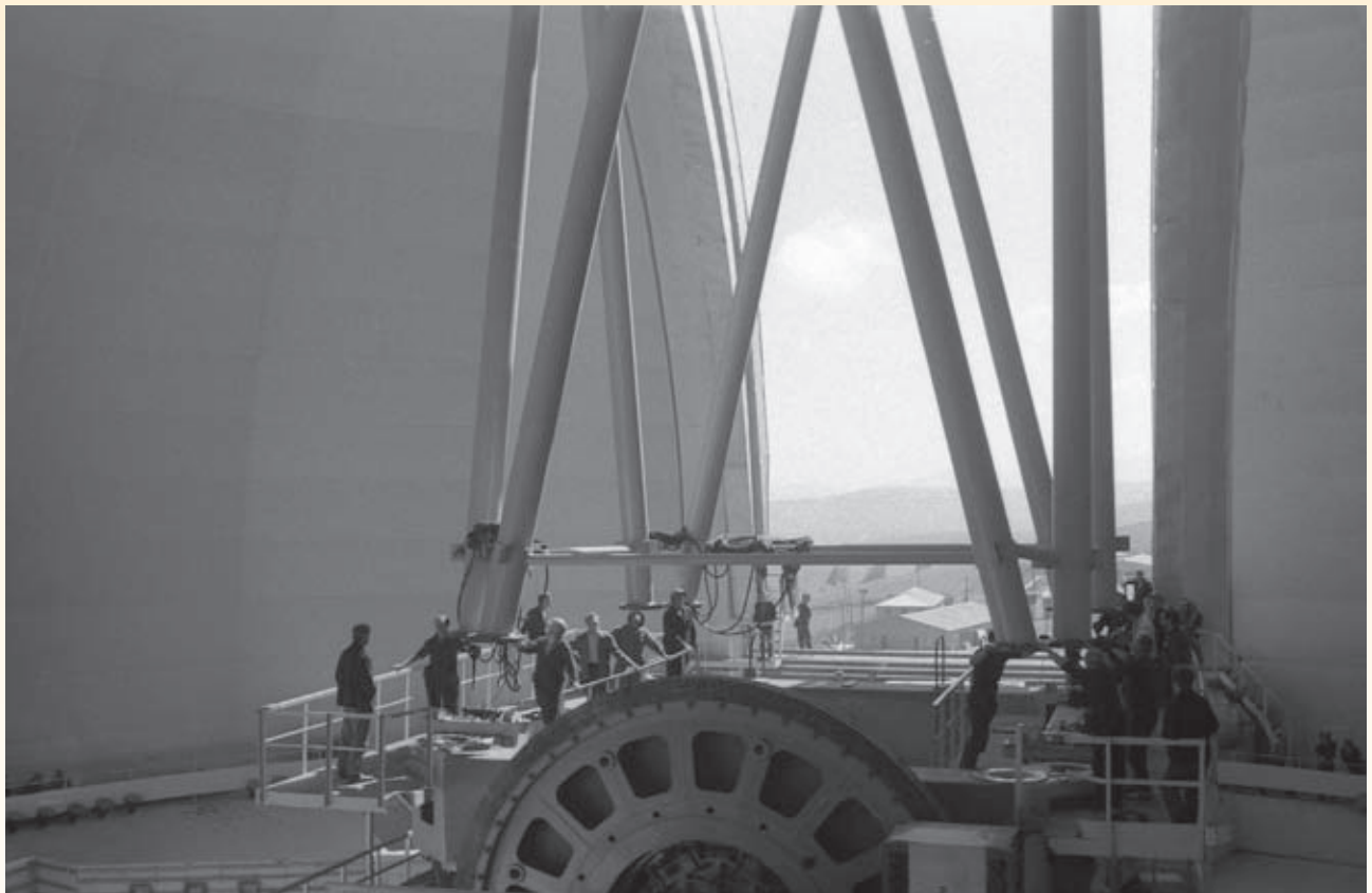
Соединение верхней и нижней частей трубчатой конструкции телескопа. Лето, 1970 г.
