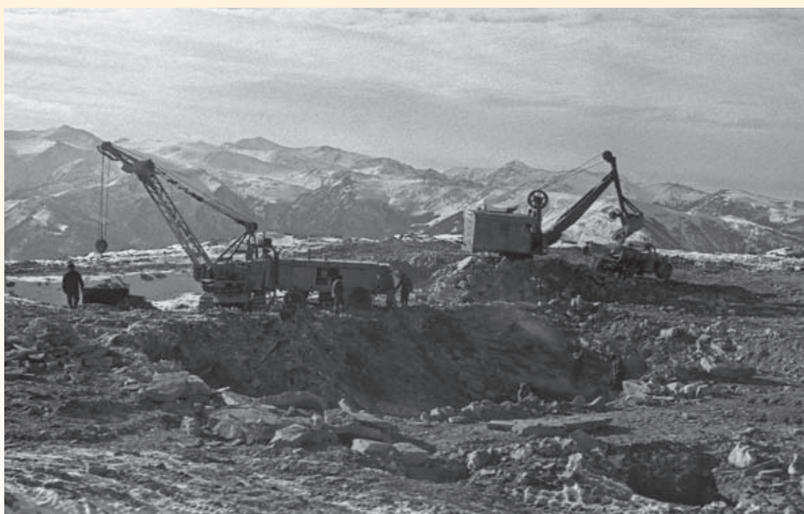
Январь, 1966 г. Подготовка котлована под фундамент телескопа БТА. В основании телескопа и башни БТА – плита камня-песчаника. Для сохранения монолитности этой плиты взрывные технологии при проходке не применялись. Работы велись практически вручную, с использованием отбойных молотков и перфораторов.
