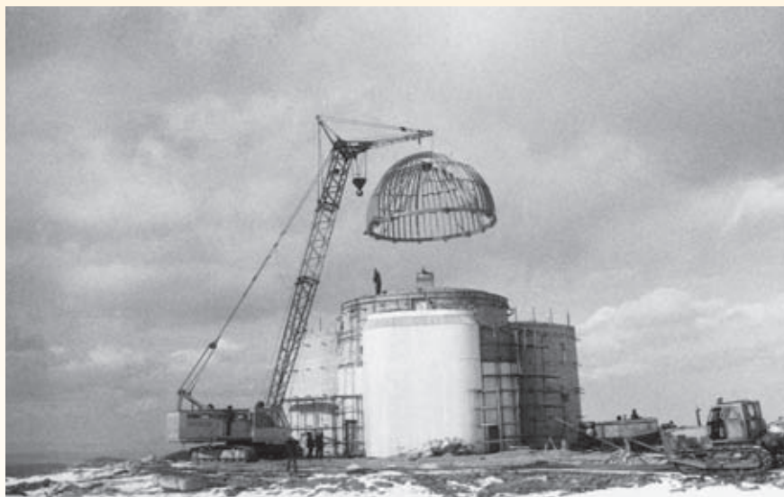
1987 г. Установка каркаса купола.
