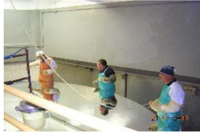
Закрепление нового слоя
