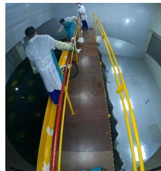
Подготовка ГЗ к алюминированию: мойка и травление старого отражающего слоя
