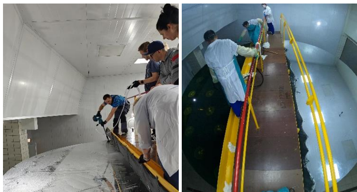
Подготовка ГЗ к алюминированию: мойка и травление старого отражающего слоя
